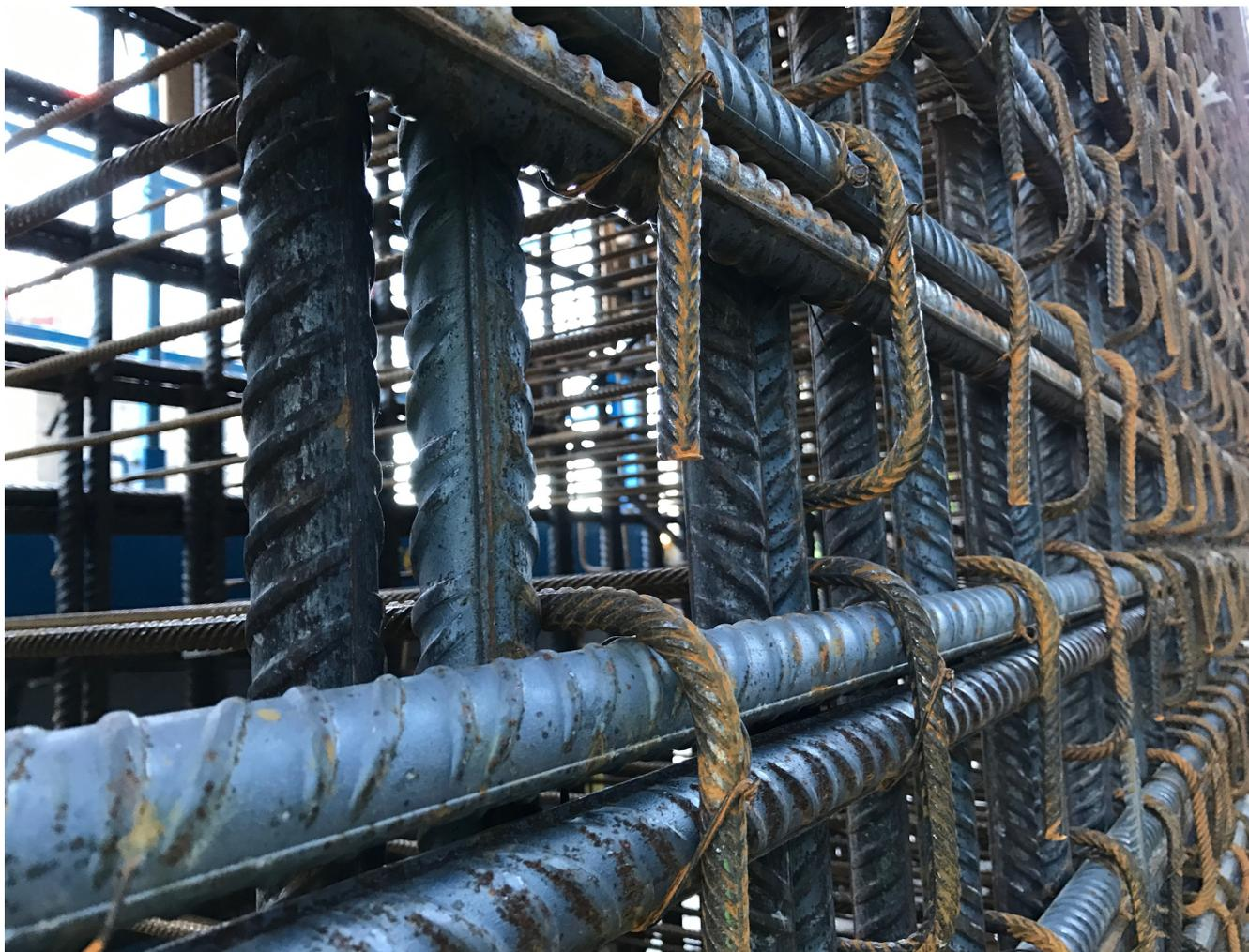
*O complexo do tokamak é uma estrutura qualificada para aplicações nucleares com betão reforçado com uma estrutura de aço muito apertada (na fotografia)*
