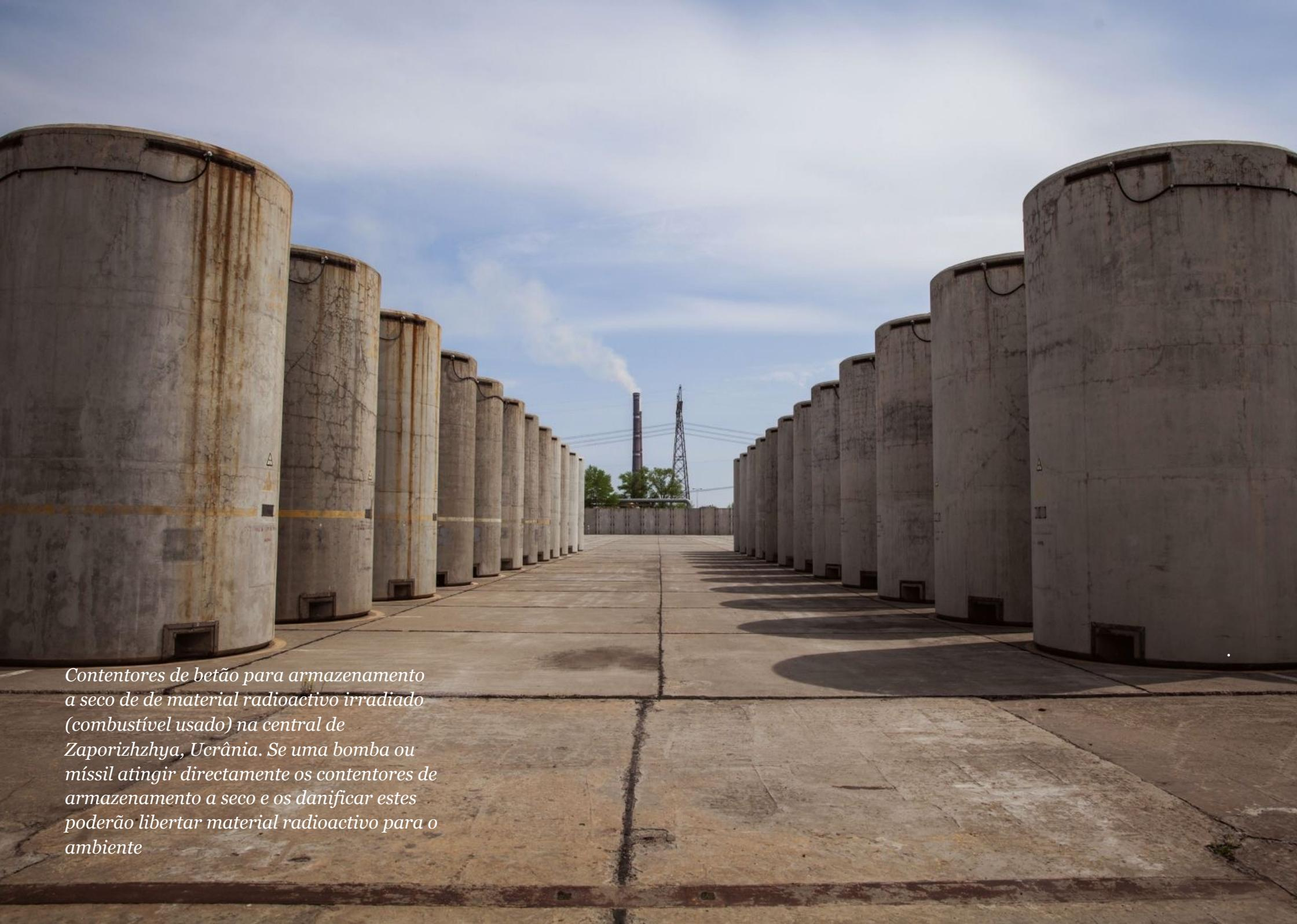
*Contentores de betão para armazenamento a seco de de material radioactivo irradiado (combustível usado) na central de Zaporizhzhya, Ucrânia. Se uma bomba ou míssil atingir directamente os contentores de armazenamento a seco e os danificar estes poderão libertar material radioactivo para o ambiente*
