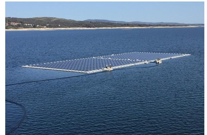
*A instalação de sistema fotovoltaicos sobre água permite a utilização de grandes áreas planas disponíveis. Além disso evitam a competição com campos agrícolas, permitindo a instalação a grande escala de sistemas de produção de electricidade com base em energias renováveis.*
