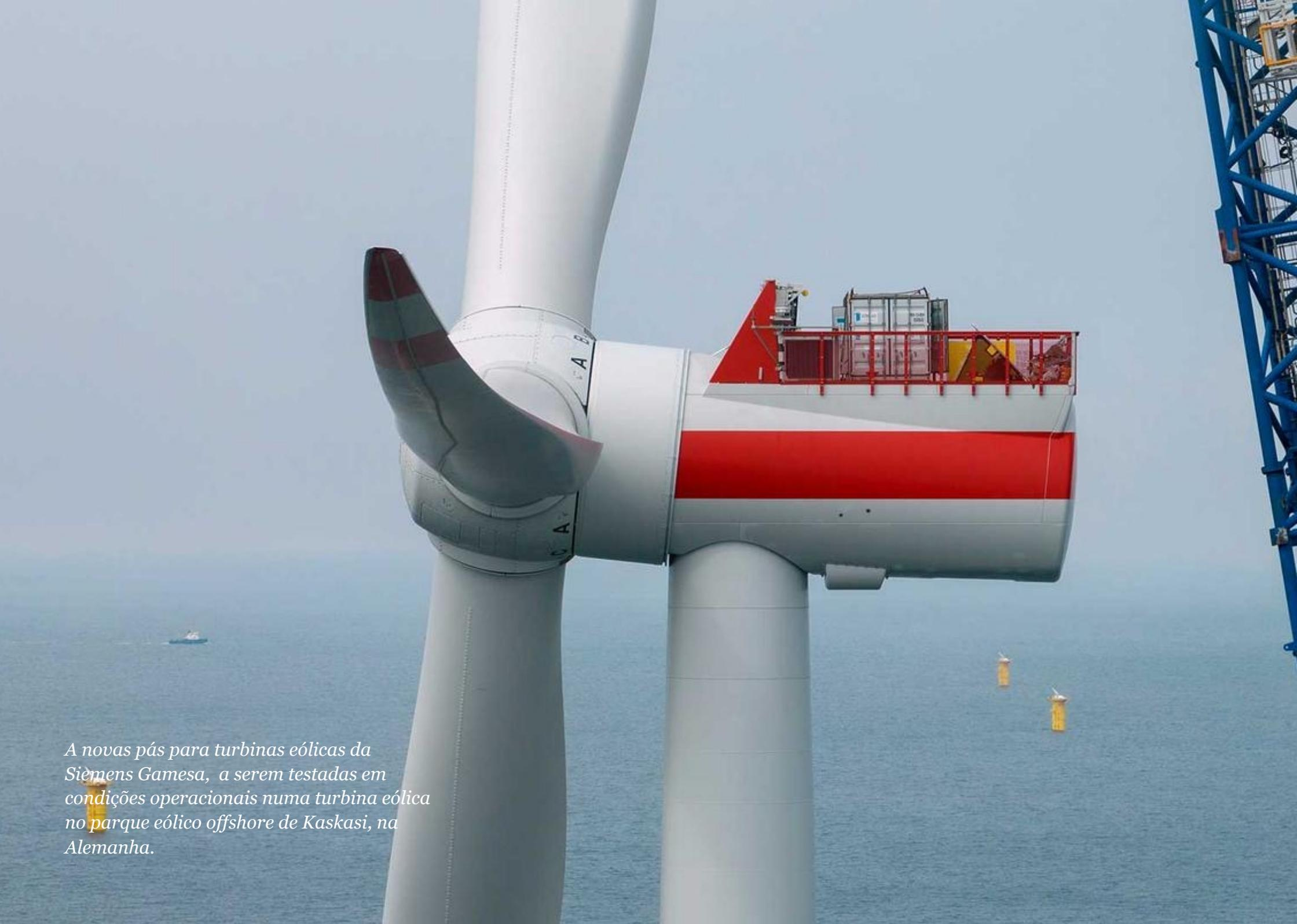
*A novas pás para turbinas eólicas da Siemens Gamesa, a serem testadas em condições operacionais numa turbina eólica no parque eólico offshore de Kaskasi, na Alemanha.*
